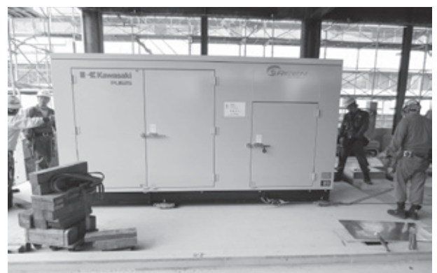
慎重に発電設備の据え付け作業を行う社員達
