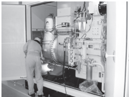
放送局の常用ガスタービン発電設備
