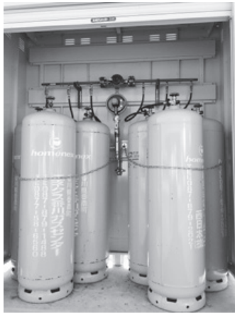
LPガスボンベ
