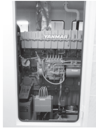
375kVA防災用ディーゼル発電設備
