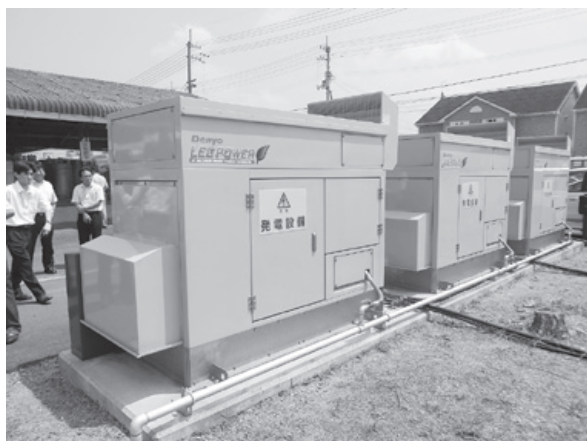
3台並列設置されたレグ・パワー
