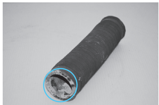
写真36：冷却水ホース内部に錆付着
