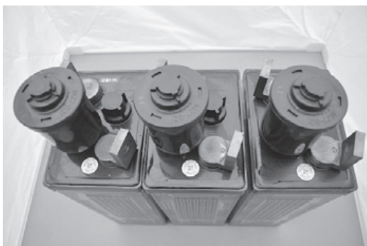
写真41：蓄電池上面の汚損
