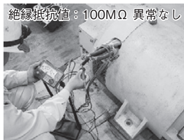
写真15：絶縁抵抗測定状況
