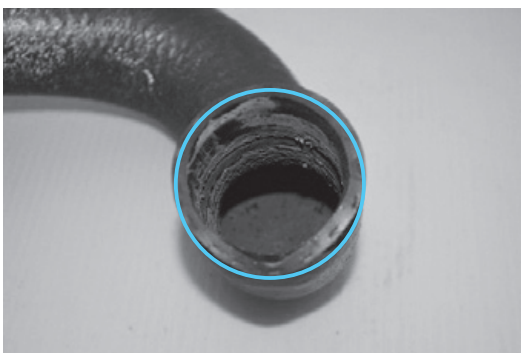
写真35：冷却水ホース内部に錆付着
