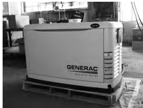
据置型の空冷式ガスエンジン 非常用発電設備 8kW（単相）
