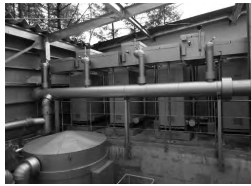
宗教施設のバイオマス発電設備（25kW×7基）
