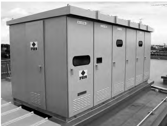
太陽光発電用高圧連系盤（500kW）
