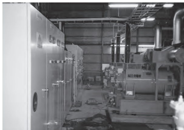
北海道の食品工場のディーゼルコージェネ(610kW×3基)
