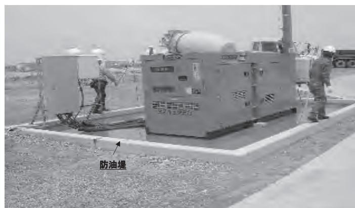
防油堤が設けられている施工事例
