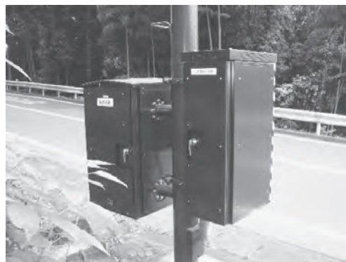
無停電電源装置（屋外装柱型）
