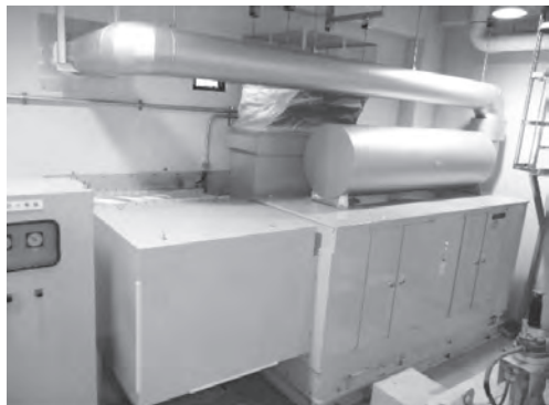
荒川水門施設の非常用発電設備（300kVA×1台）
