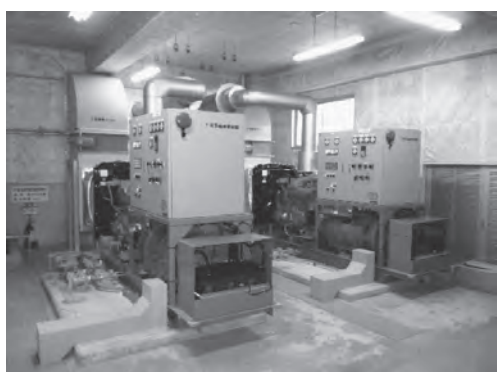
某ダム管理所用非常用発電設備（150kVA×2台）
