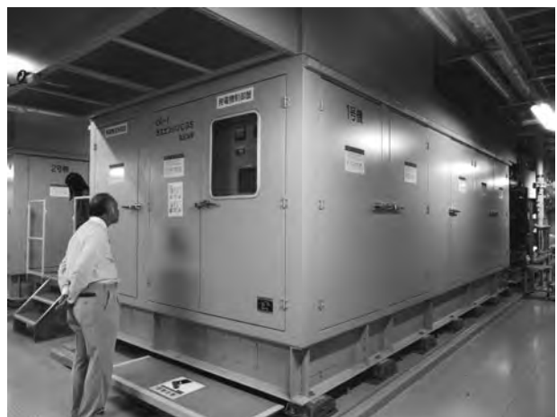
ガスエンジンコージェネ930kW
