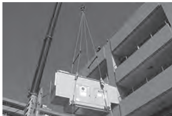
発電装置のクレーン搬入光景
