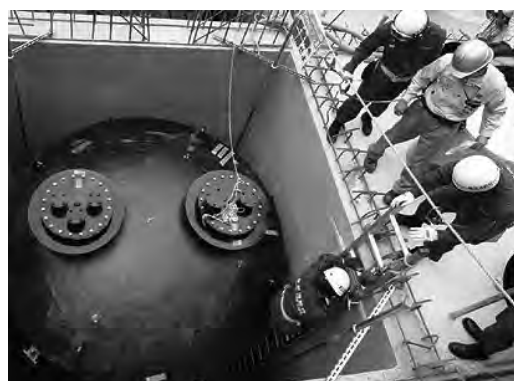
縦置円筒型地下タンクの検査（東京消防庁HPより）
