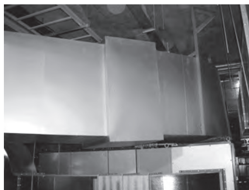
地下鉄施設内の入り組んだダクトの施工
