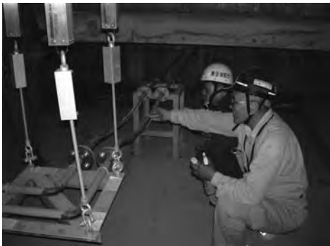
免震フレキシ型燃料配管の消防検査
