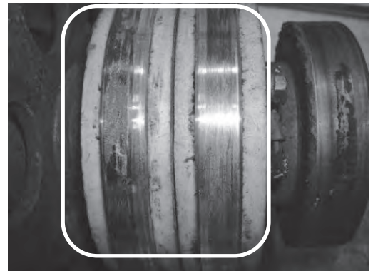
写真3 スリップリング部の摩耗
