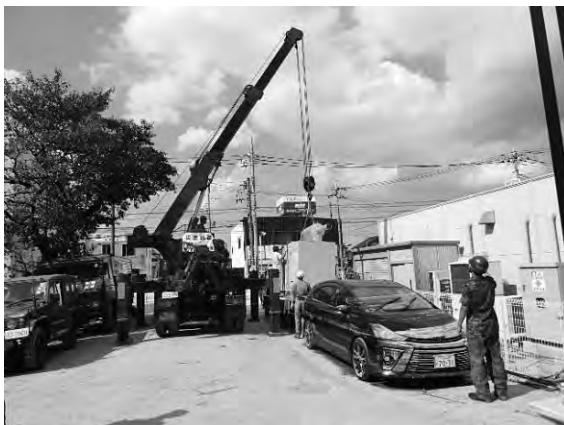
自衛隊員らとの協働による発電設備設置作業
