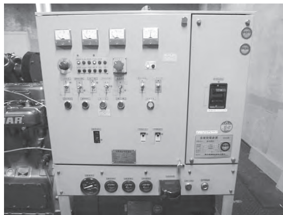
当時の発電設備用制御装置（昭和53年）
