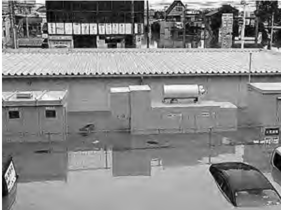
浸水した常総市庁舎の非常用発電設備
