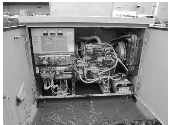
汚泥が入り込んだ発電設備
