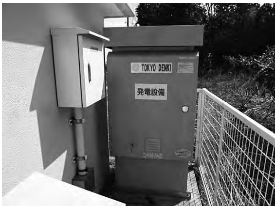
モニタリングポストと非常用発電設備（平成18年）
