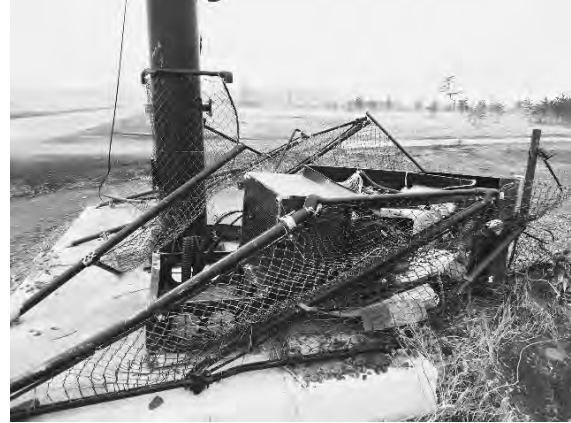
宮城県東松島市の被災した発電設備
