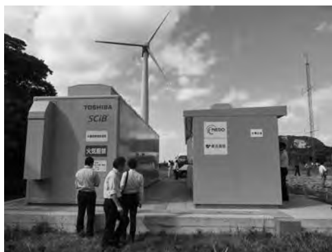
左はリチウムイオン蓄電池システム 右はパワーコンディショナー
