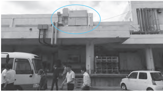
青丸囲み部分は製氷用チラー設備
