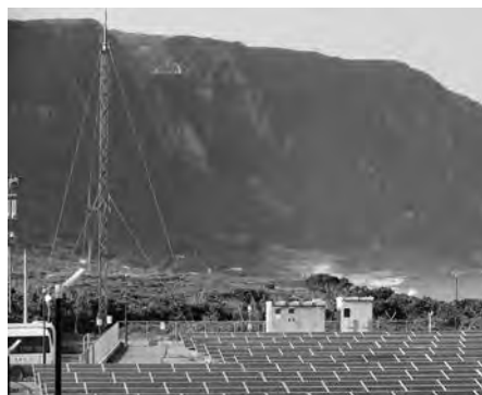
太陽光発電設備（318kW）
