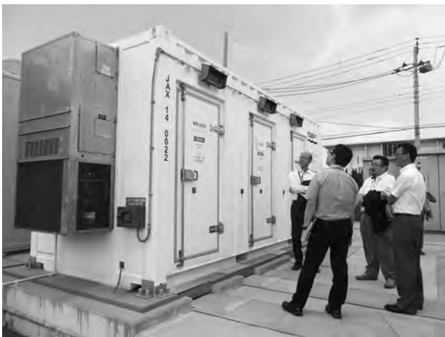
東光高岳電気所のサフト（Saft）製蓄電池設備
