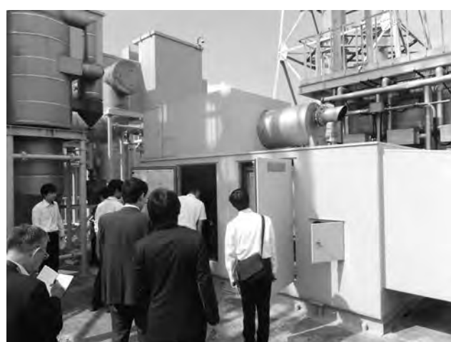
新島内燃力発電所に設置された非常用発電設備
