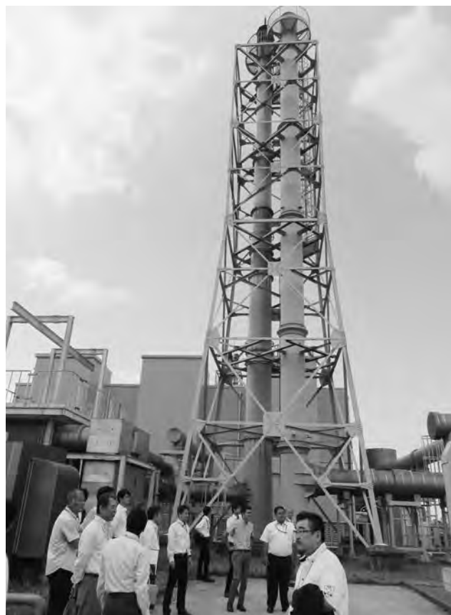
ディーゼル発電設備の排気用の煙突
