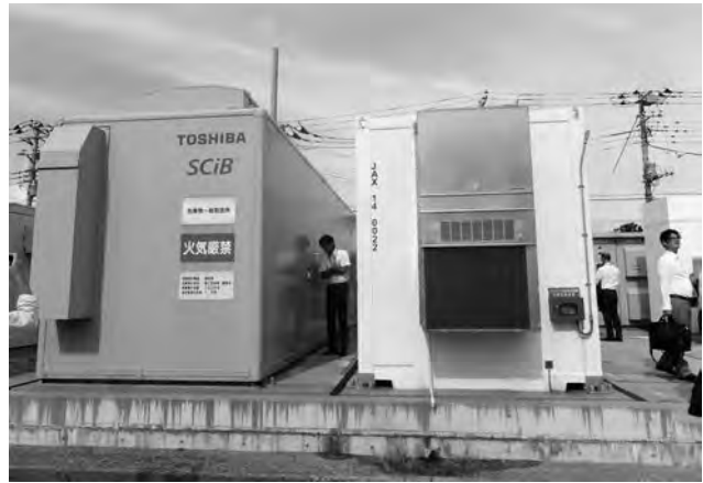
東光高岳電気所の蓄電池設備2台（新島内燃力発電所内）
