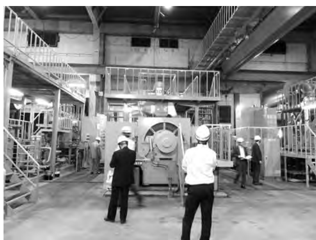
新島内燃力発電所のディーゼル発電設備室
