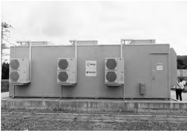
東光高岳電気所の東芝製蓄電池設備
