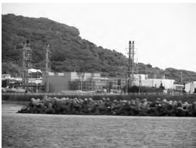
東京電力の新島内燃力発電所の外観
