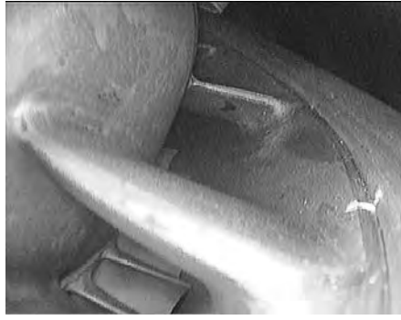
図2 長時間無負荷運転後の第1段タービンノズル性能に影響がない軽微なカーボンの付着が見られた。
