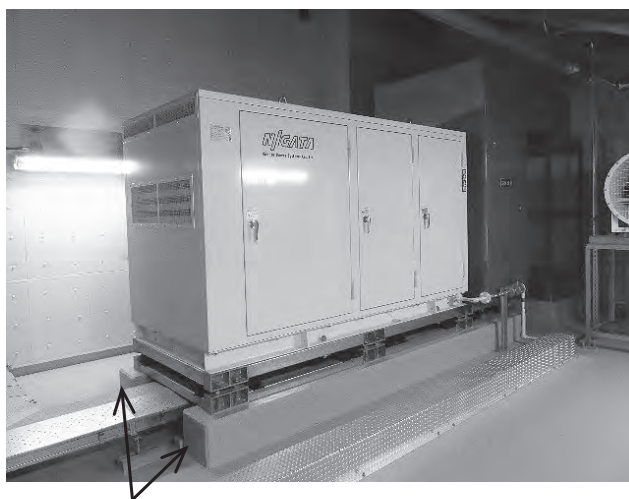
「ゲタ基礎」を用いた自家発電設備
