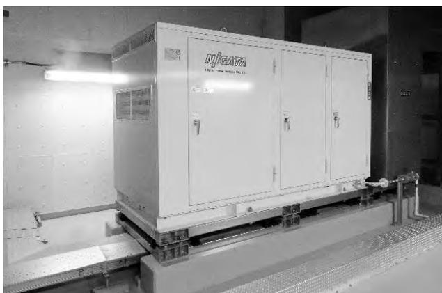
自家発電設備（ガスタービン駆動500kVA×1基）
