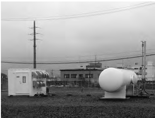
災害時用の燃料電池発電設備と自営線 (左：燃料電池ユニット 右：水素タンク)
