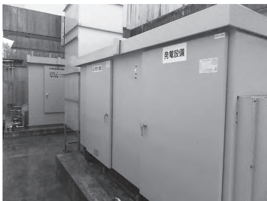
新病棟の自家発（400kVA×1基）
