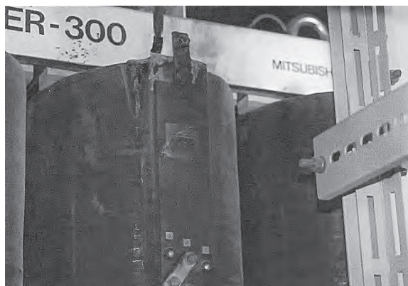
相間短絡を起こしたレントゲン室系の変圧器
