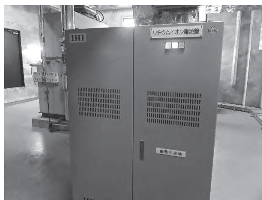
リチウムイオン電池設備
