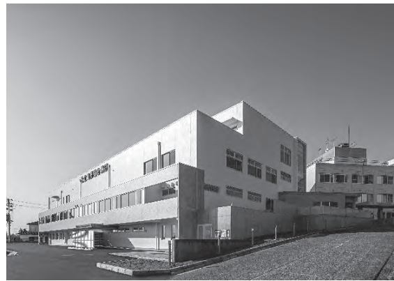
公立相馬総合病院（手前が新病棟）
