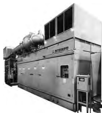
SGP M1000（発電出力1,000kW）
