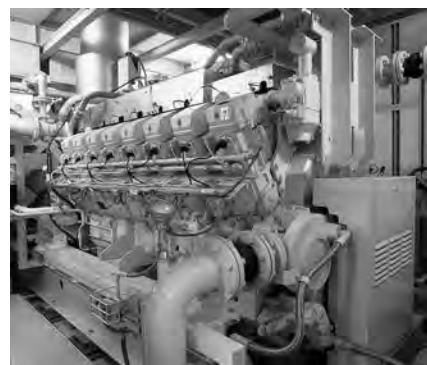
高速ガスエンジンGSRを搭載した常用コージェネSGP M930（発電出力930kW）
