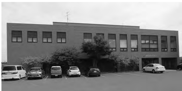
敷島機器株式会社 本社社屋
