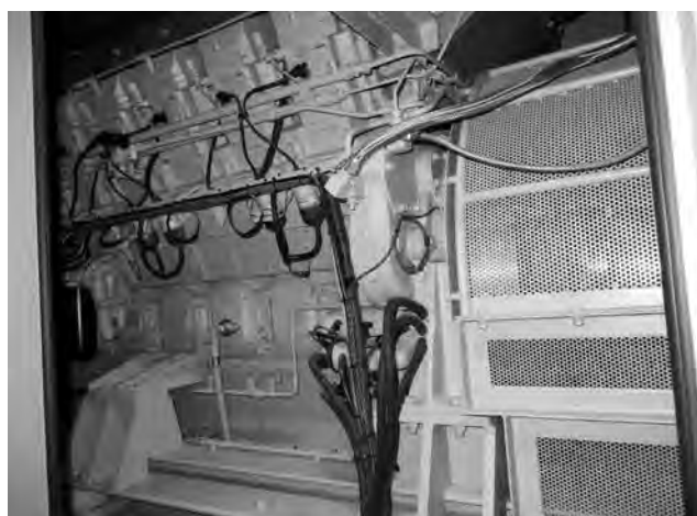
写真4 CGSに搭載されたガスエンジン
