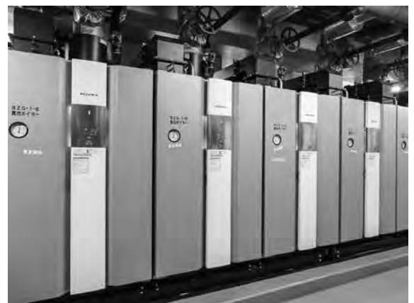
熱源機械室の蒸気ボイラ (ガス専焼3t/h×6基、ガス・油切替2t/h×2基)
