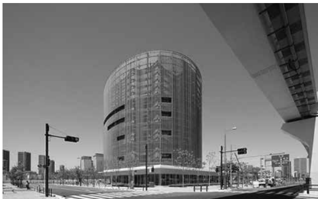
豊洲スマートエネルギーセンター外観 (東京ガス(株)HPより)
