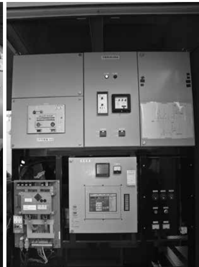
上段左から屋内1号発電機、屋外2号発電機、 下段左から1号発電機盤、2号発電機切替盤、 2号制御盤
