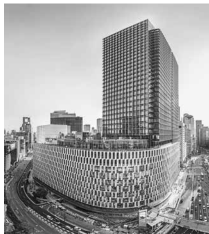
大阪梅田ツインタワーズ・サウス全景
