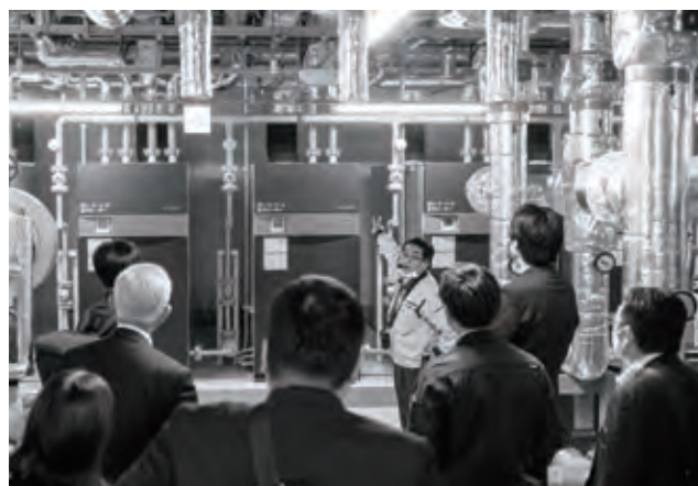
昭和銅板製の真空式温水ヒーター 定格出力930kW
