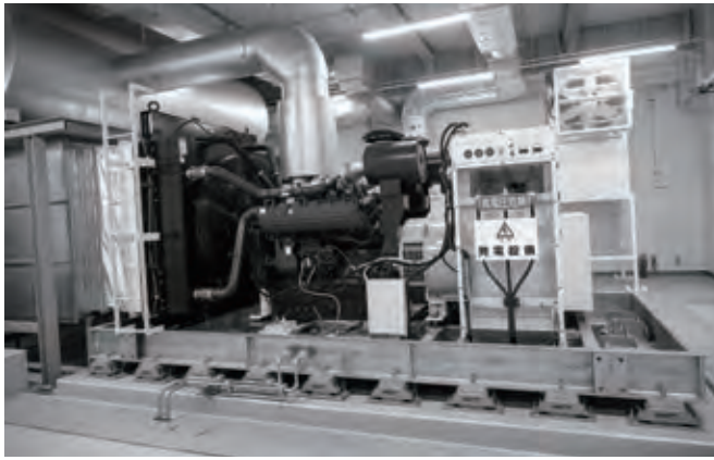
自家発は電力途絶時には72時間以上の稼働に対応できる
