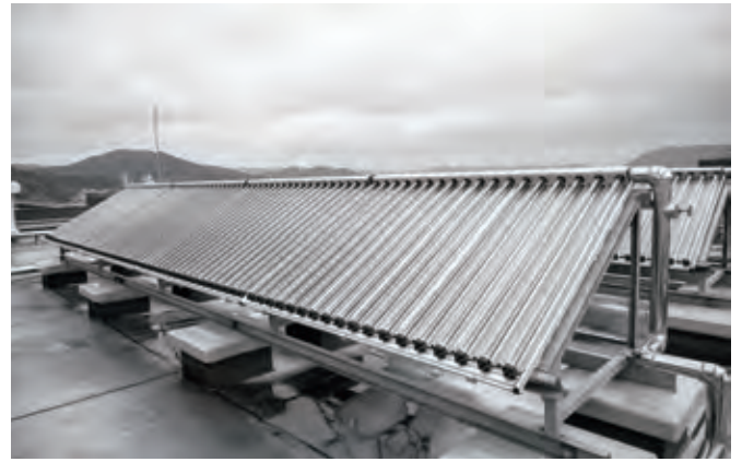
市庁舎の屋上の太陽光集熱システム
