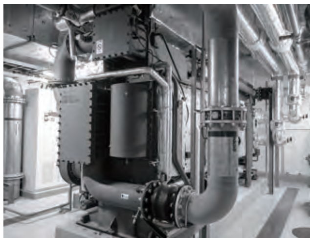
排熱投入型吸収式冷温水機
