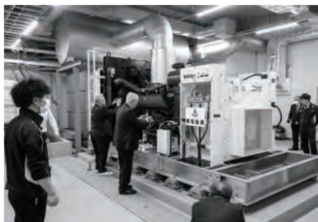
写真上は認証票。出力800kW・40秒始動の防災用自家発電
